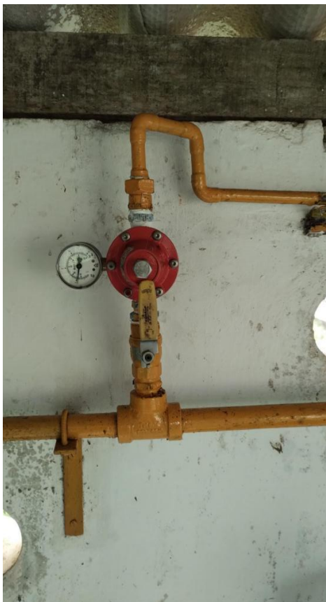
Figura 2- Troca do regulador de pressão da Central de gás
