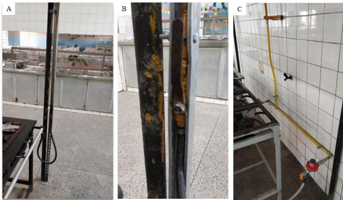
Figuras 1: A e B - Instalação de cantoneiras; C - Troca parcial da tubulação de GLP
